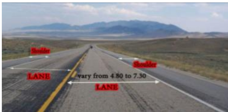
صورة رقم (1-6): توضح أكتاف الطريق
