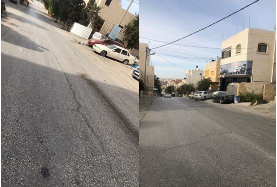
صورة رقم (3-6) شقوق طوليه وعرضيه
