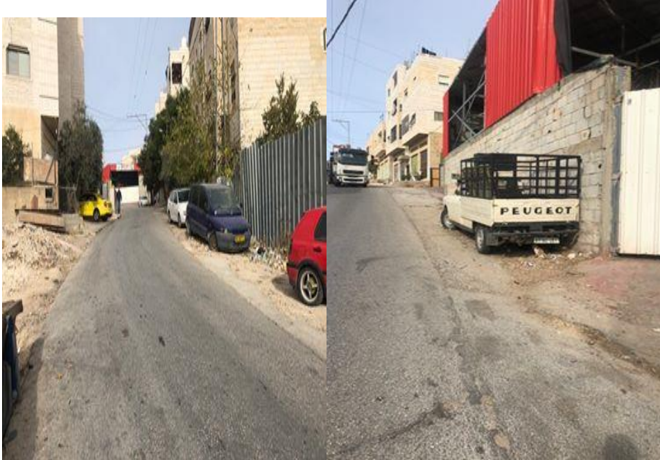
صورة رقم (4-3) مشاكل الطريق
