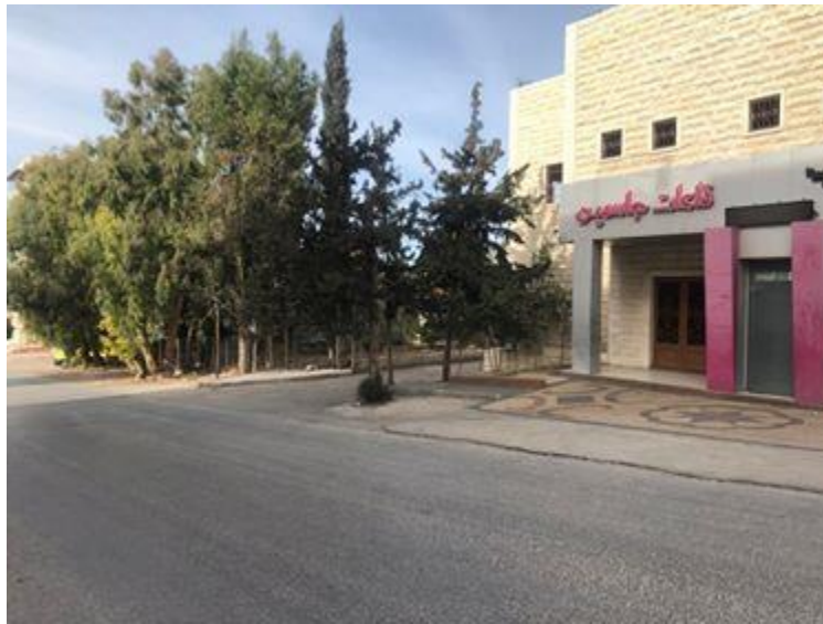
صورة رقم (3-3) مشاكل الطريق
