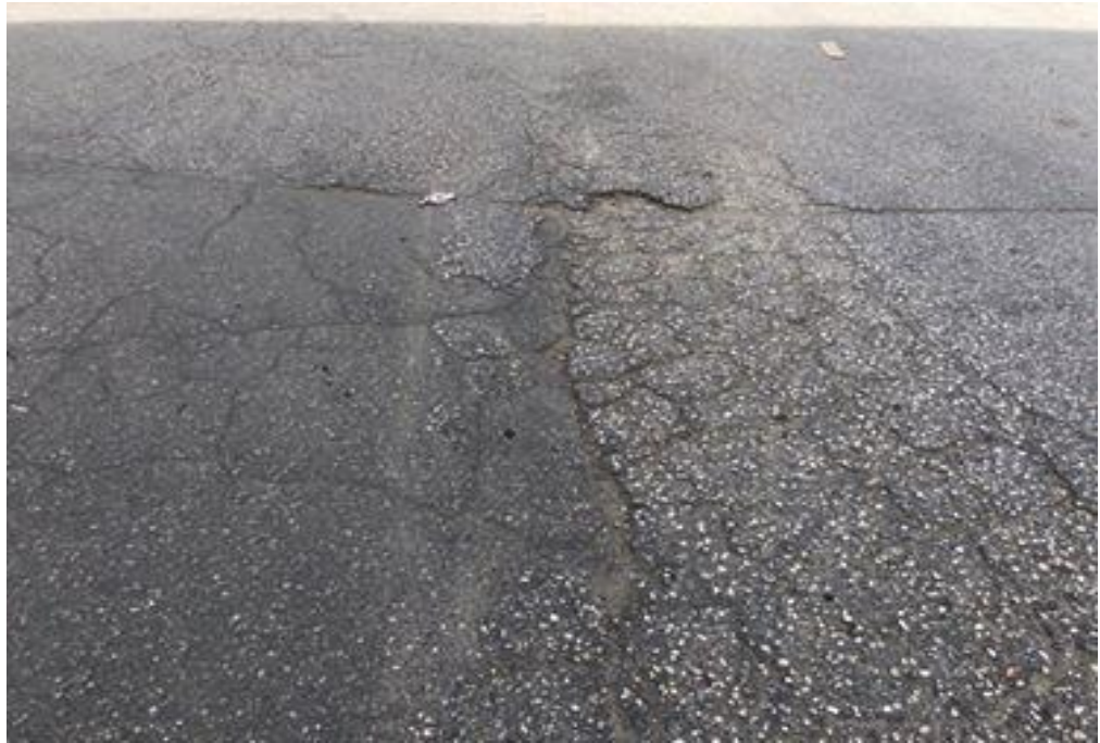
صورة رقم (8-3) الهبوط
