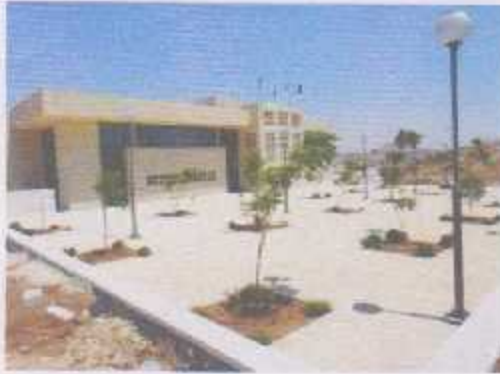
شكل (٢-٥) مبنى الإدارة ببيت لحم بيت لحم المصدر: (سلطة الطاقة الفلسطينية، ٢٠١٤-١٢-٣)
