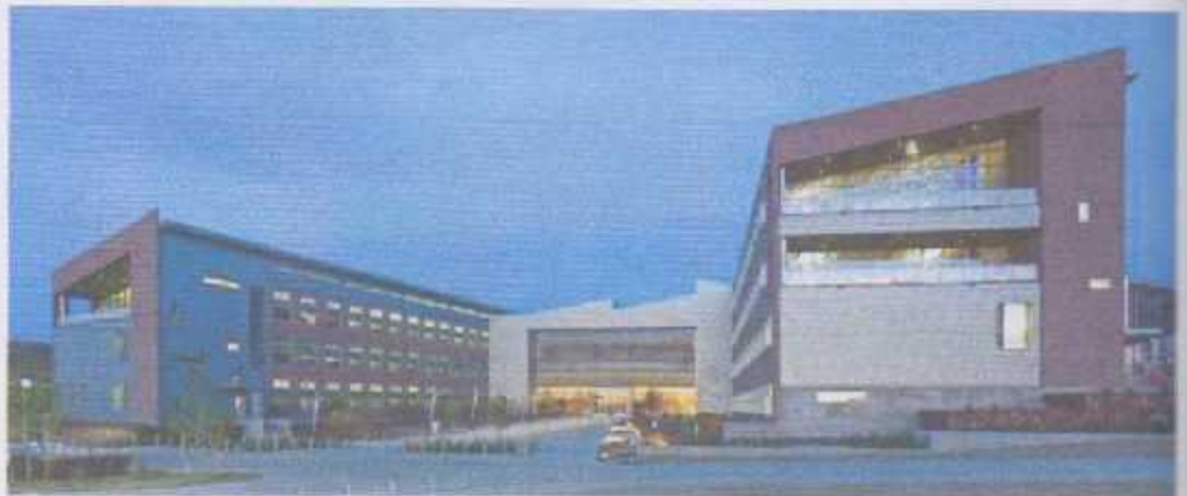
شكل (٢٨-٥) مبنى قسم الإدارة (مبنى الدعم) المصدر: (WWW.Nrel.gov/building)
