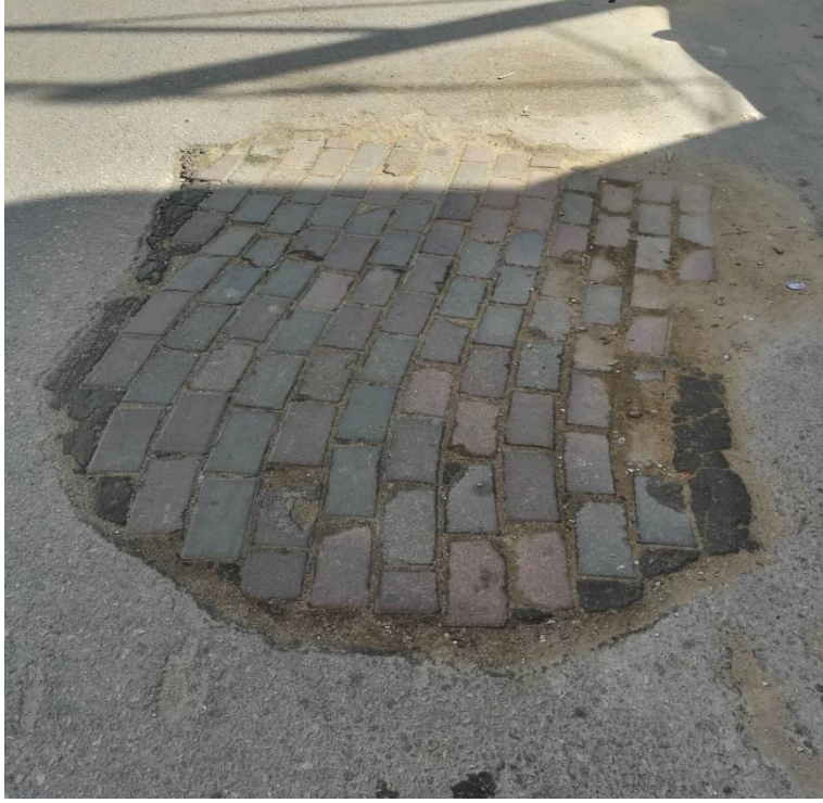
صورة (15-1): الرقع باستخدام مادة غير الأسفلت في طريق المشروع
