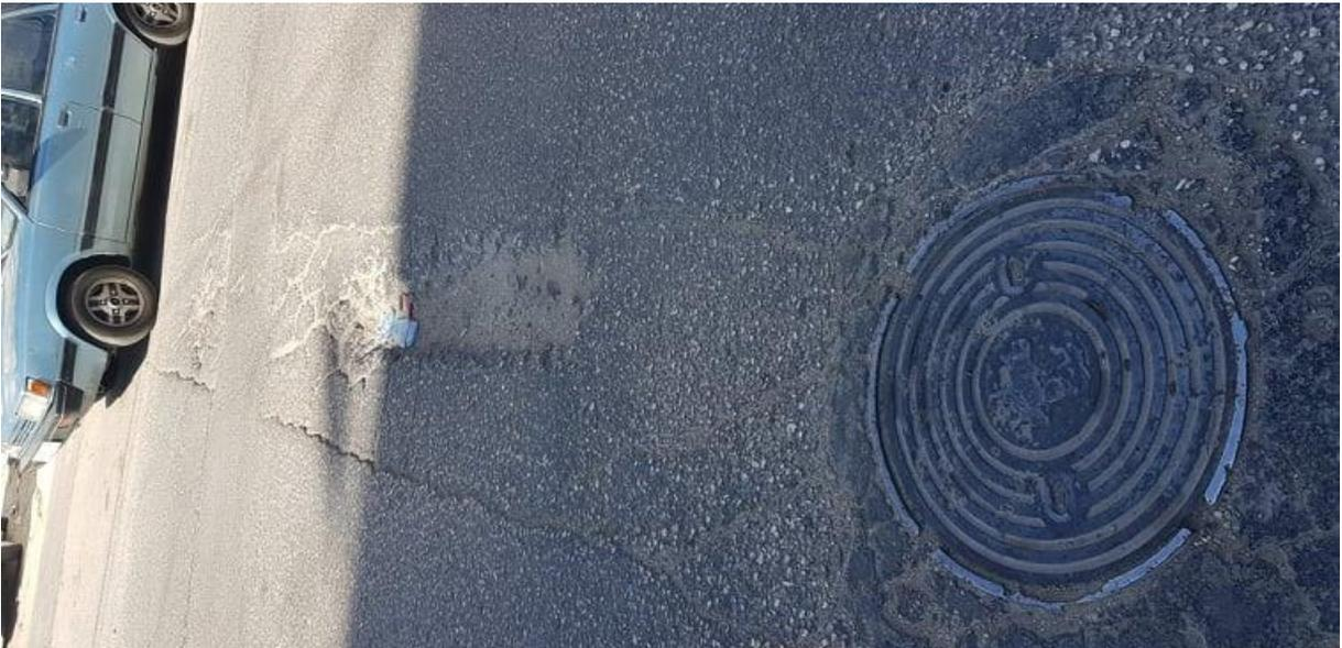
الشكل رقم (5-22): حفر في الترقيع تتجمع فيها المياه.
