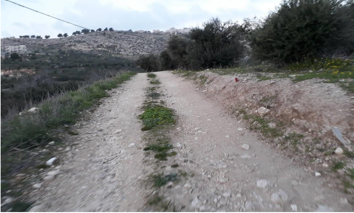
الشكل ( 3-3 ) يوضح ضيق الطريق .
