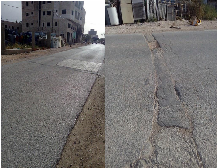
الشكل (3-5) انهيارات التربة .
