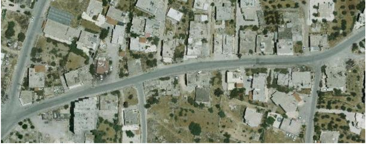
الشكل (3-3) ضيق الطريق.
