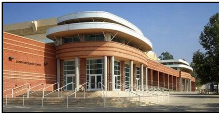
الشكل (3-4): المبنى القديم.
