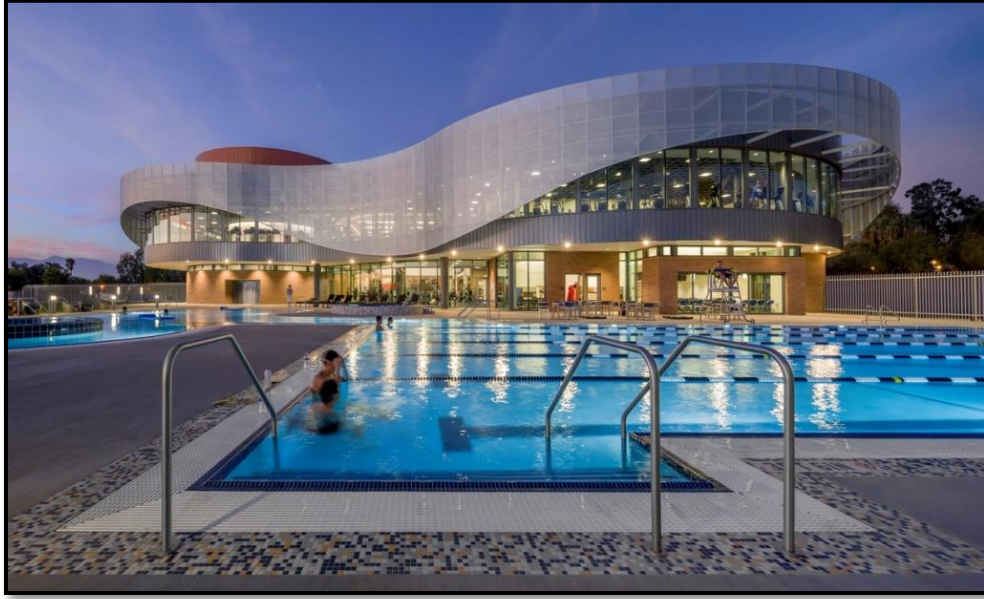
الشكل (4-27): الواجهة الجنوبية
