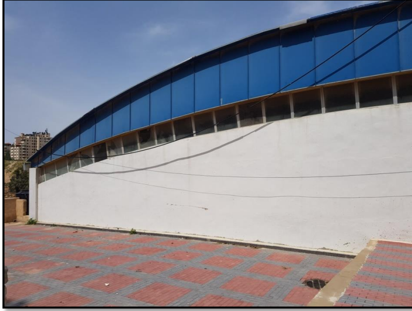
الشكل (4-64): الواجهة الجنوبية
