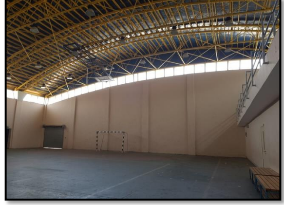
الشكل(ج-1): داخل الصالة الرياضية متعددة الأغراض ويظهر المدرج
