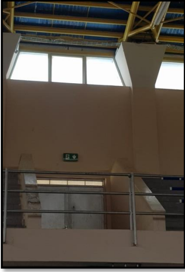
الشكل(ج-3): مخرج طوارئ من جهة المدرج المصدر: الباحثان
