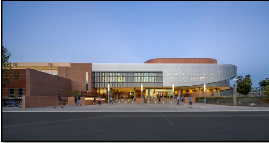
الشكل (4-29): الواجهة الغربية
