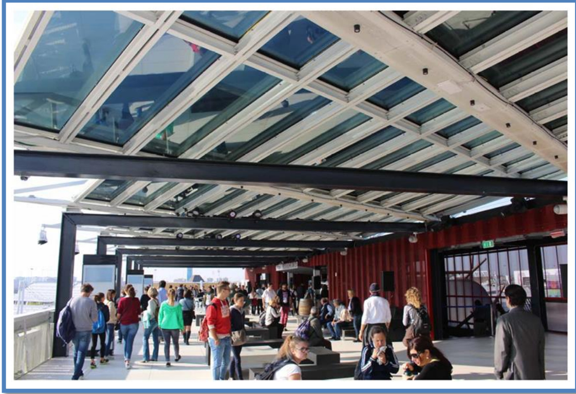
الشكل (4-30) تغطية السقف من اللوحات الإلكترونية "SPD-Smart Glass"
