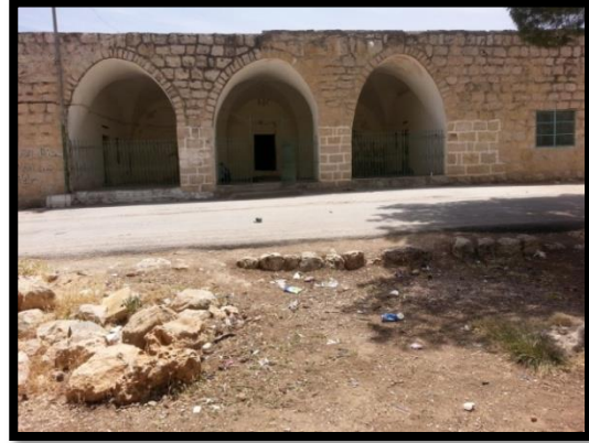
الصورة (٤-٩) الواجهة الشمالية قبل الترميم المصدر: (الباحثان)
