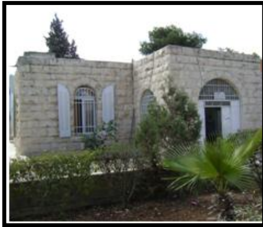
الصورة (٤-٢٨) الواجهة الشمالية قبل الإضافات
