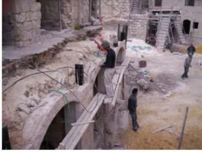
ربط الواجهة الجديدة بالقديمية
