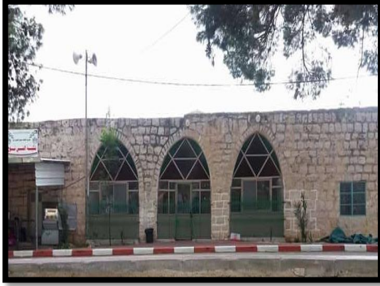
الصورة (٤-١٠) واجهة المقام بعد الترميم المصدر: (الباحثان)
