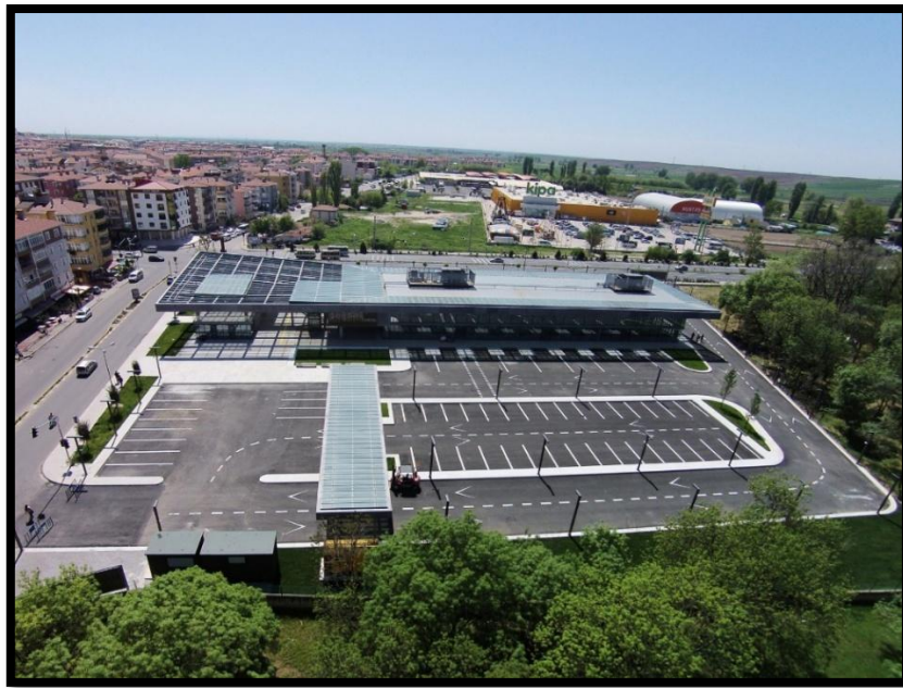
صورة 2-4 المنطقة الجنوبية للمحطة ومدخلها - المصدر archdaily
