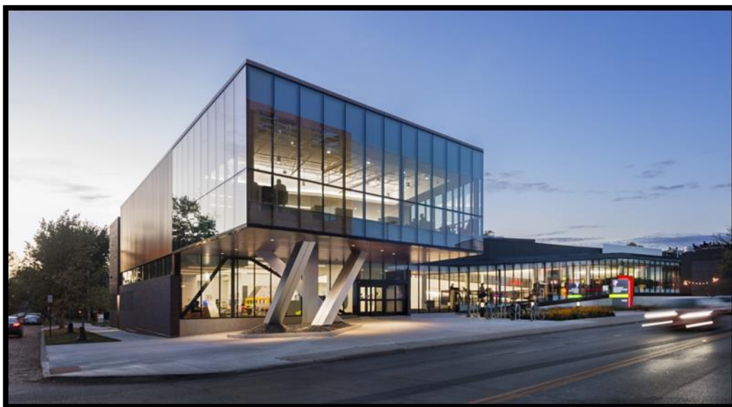
الشكل (4-15) صورة توضح الكابولي المصدر: ( http://www.Archdaily.com )
