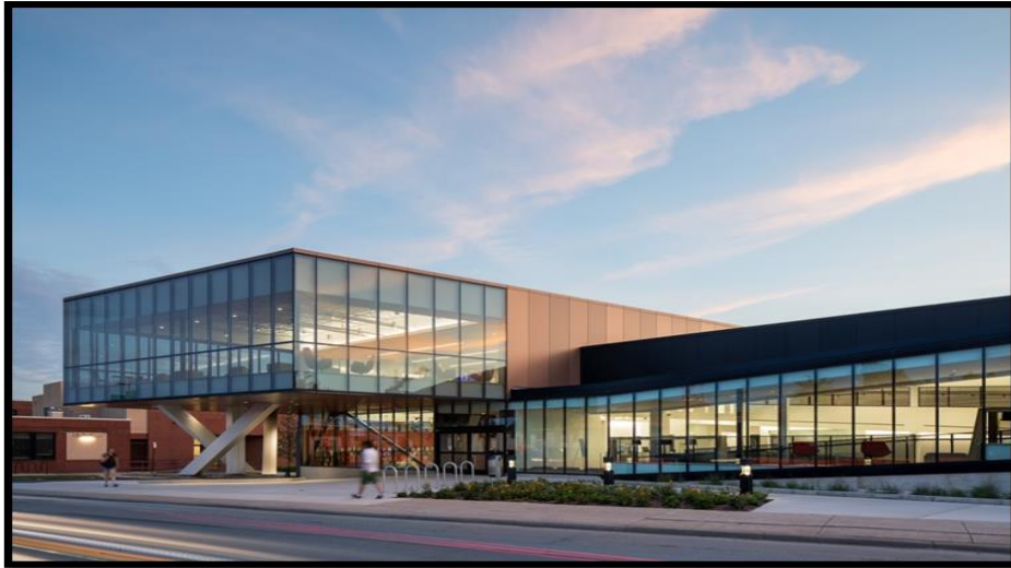
الشكل (4-20) مبنى المكتبة المصدر : ( http://www.Archdaily.com )
