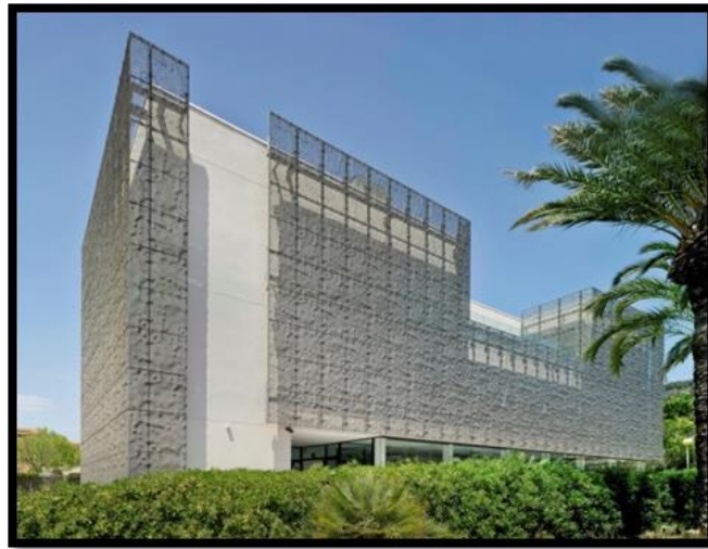
الشكل(4-2) صورة توضح المعدن المغلف للمبنى المصدر : ( http://www.Archdaily.com )
