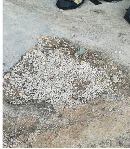
الشكل (3-3) : وجود الحفر بالطريق
