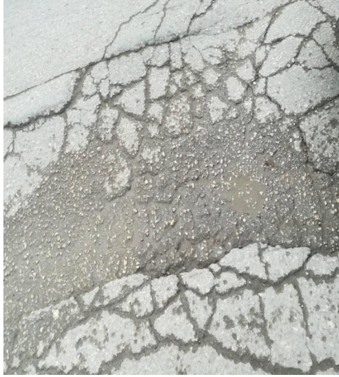
الشكل (3-3) : وجود الحفر بالطريق
