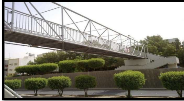
الشكل ٤-١٩: جسر مشاة حديدي. [14]
