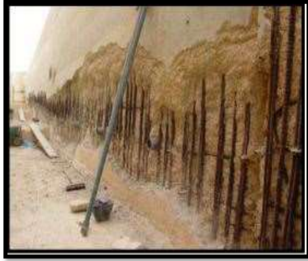
الشكل ٤-١٣: يوضح تصدع الجدار الاستنادي. [14]
