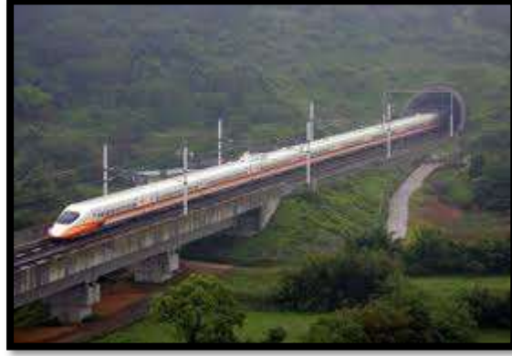
الشكل ٤-١٨: جسر سكة حديدية. [14]
