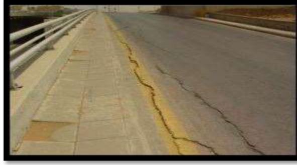
الشكل ٤-١٥: الهبوط في الطبقة الأسفلتية بمحاذاة الجدار الاستنادي. [14]
