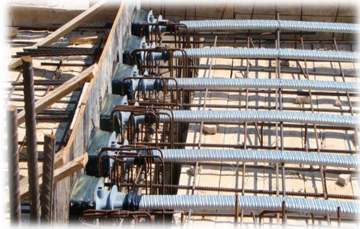
الشكل (٣-٧): العقدات اللاحقة الشد (Post tension).
