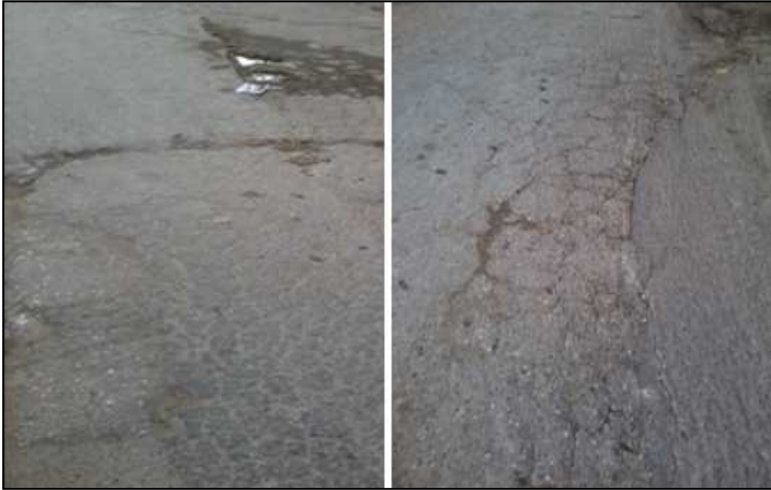
( - ) عيوب التشققات في الطريق
