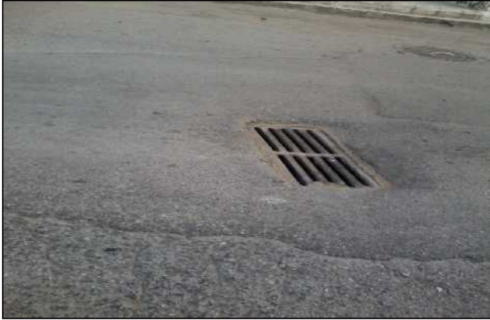
( - ) فتحة تصريف المياه الوحيد بداية شارع المنشر
