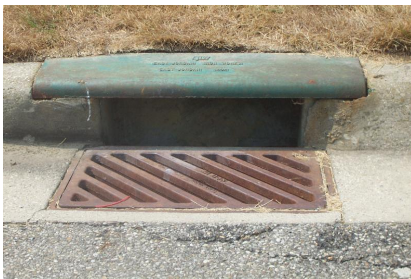
الشكل (2-2) شكل فتحات التصريف على جوانب الطريق.
