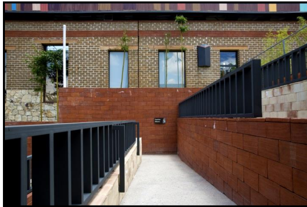
الشكل(4-38): المنحدرات المحاطة بالجدران المبنية من الطوب الطيني او الحجر المحلي
