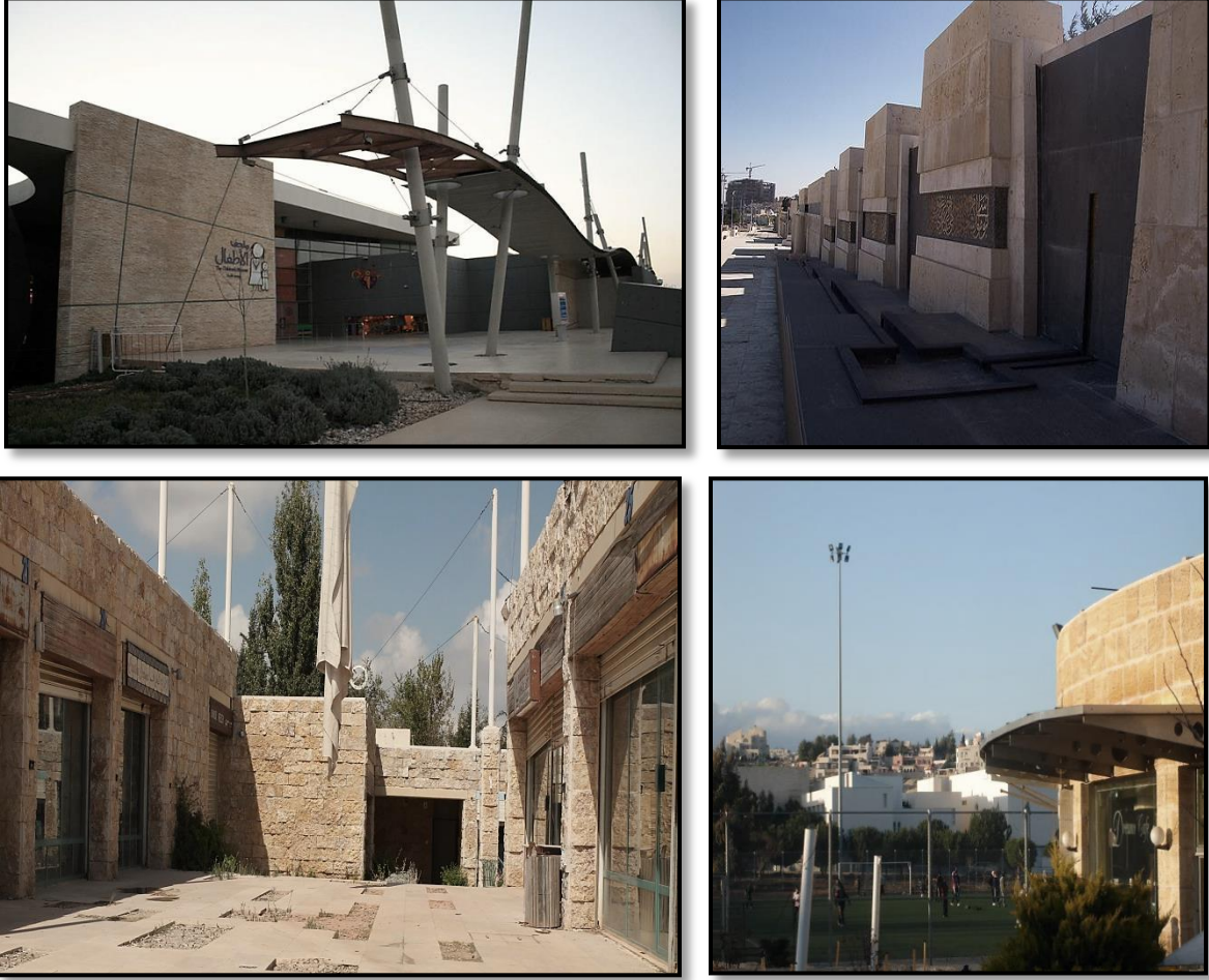
الشكل(4-26) : يوضح التنوع في استعمال مواد البناء
