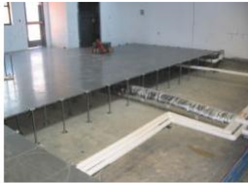
شكل(4.4) يوضح نظام توزيع الهواء تحت الأرض في فراغات مدرسة فورك المصدر: (Innovative Design, 2008)
