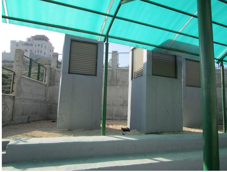
الشكل (14.4) ملاقف التبريد الخارجية، (المصدر: الباحث)
