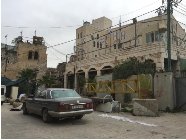
الشكل 4-5: صورة لمبنى مدرسة أسامة بن المنقذ الذي استولى عليه الاحتلال .
