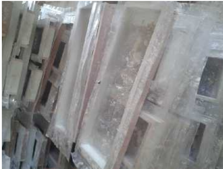
صورة ( - ) :القالب بعد تجهيزه مثبت بلوح خشبي حتى يسهل إزالته بعد صب الخلط وتصلبه - البيتم لمواد البناء - فريق العمل .
