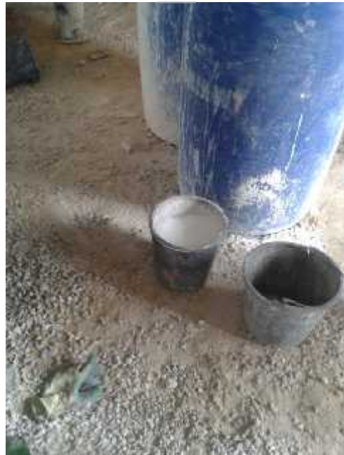
صورة ( - ) : المادة الخاصة بعد تدويبها في الماء تعمل كمادة رابطة لمكونات الخلط وتحضر من الأردن - اليتيم لمواد البناء - فريق العمل .
