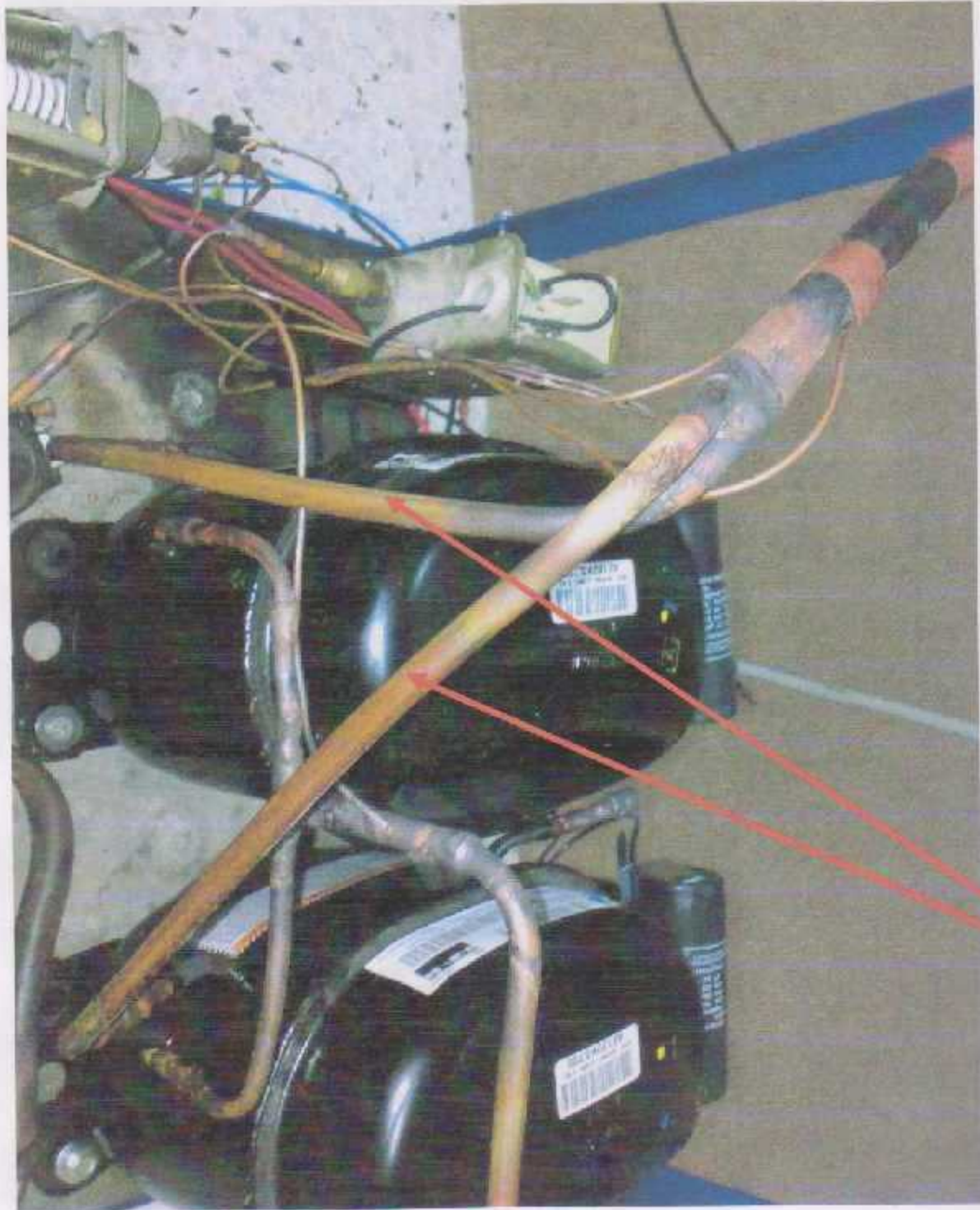
شكل (1.1): خطوط السحب (المواسير ذات الأقطار الأكبر).
