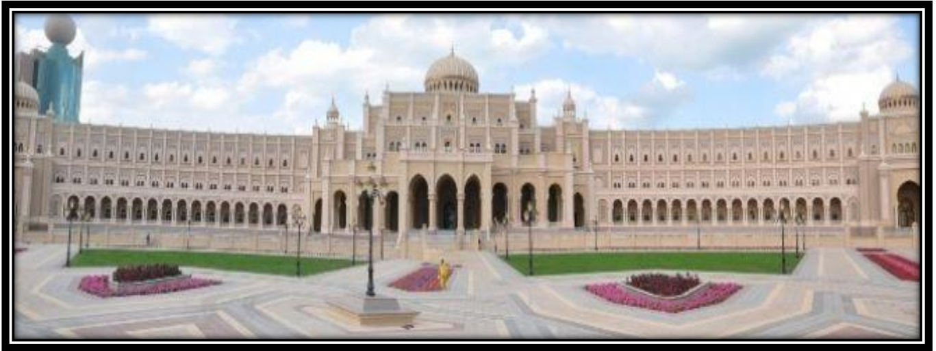
صورة (٢٥-٥) الواجهة الامامية للبلدية مع المدخل الرئيسي
