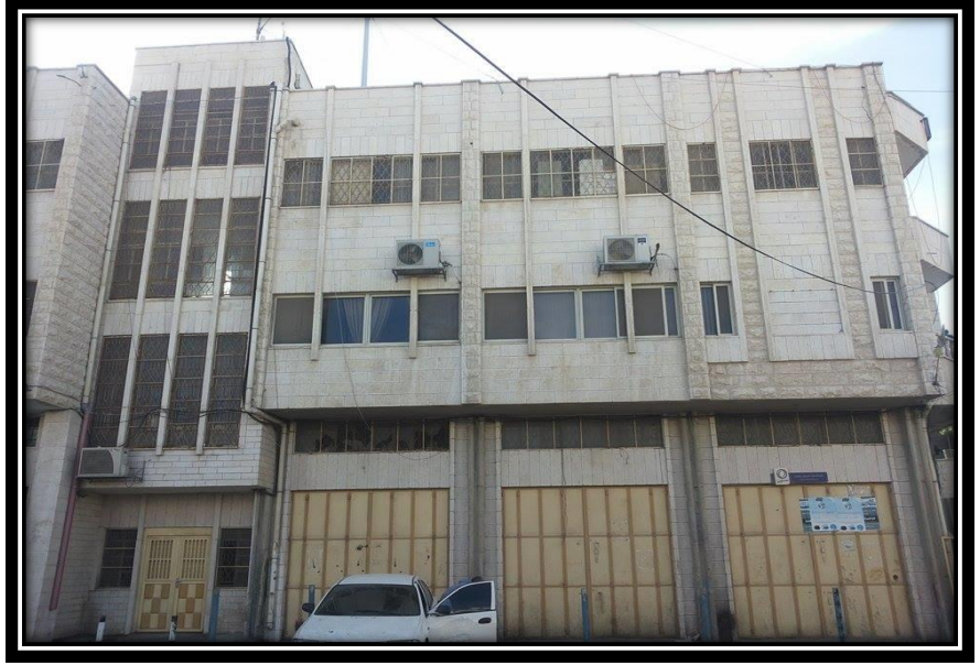
صورة (٥-٨) الواجهة الشمالية الشرقية لمبنى البلدية المصدر : فريق العمل
