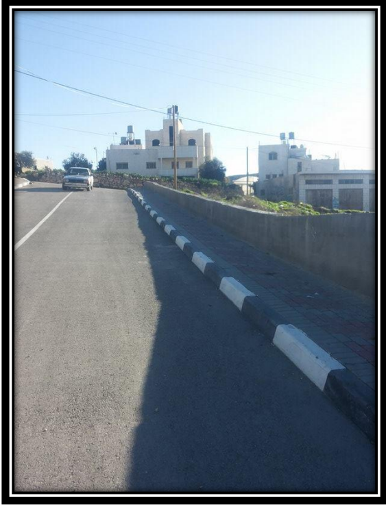
صورة (٦-١١) : صورة للشارع الفرعي
