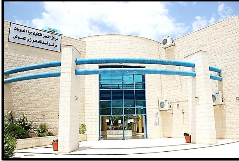
شكل (٣.٣) المدخل الرئيسي للمبنى . المصدر: (كاميرا الباحث).
