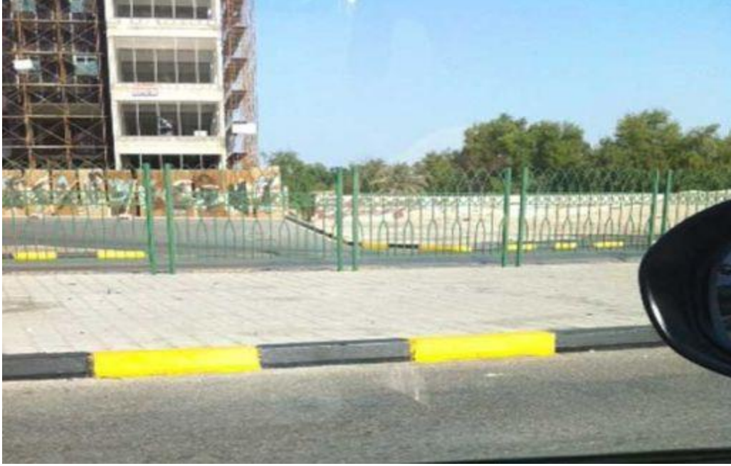
الشكل(2-3) الرصيف بجانب منشأة عامة 1
