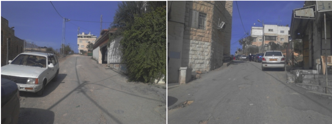
الشكل ( - ) اعتراض المباني لتوسعة الطريق ( / / )
