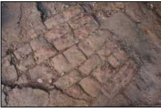
الشكل ( - ) : تأكل المادة الرابطة بين البلاط الحجري . المصدر: - فريق العمل / /
