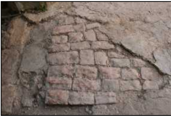
الشكل ( - ) : تغطية البلاط الحجري بالمدة الخرسانية المصدر:- فريق العمل / /
