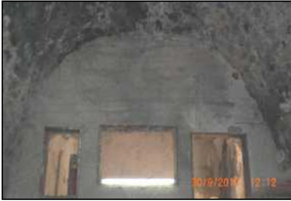
الشكل ( - ) : العقد البرميلي المستخدم في بعض الفراغات. المصدر:- فريق العمل //
