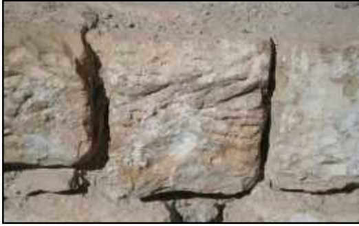
الشكل ( - ) : سقوط الكحلة من الحول الحجري . المصدر: - فريق العمل / /
