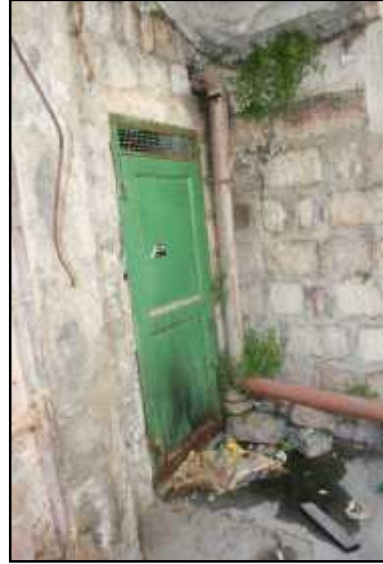
الشكل ( - ) : ظهور التمديدات الصحية وتسببها بالعفن. المصدر: - فريق العمل \ \
