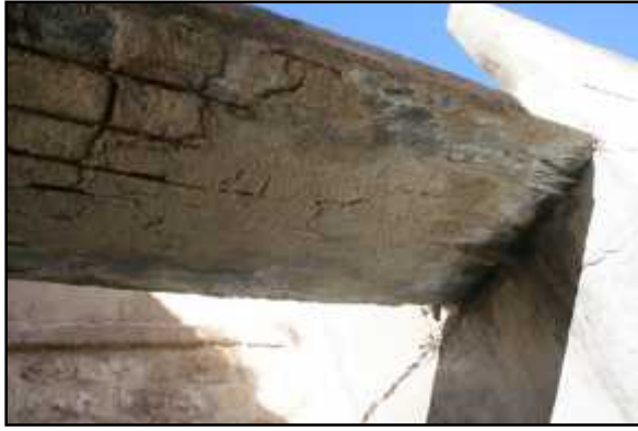
الشكل ( - ) : استخدام العقود المستقيمة والأسقف الخرسانية المسلحة. المصدر:- فريق العمل / /
