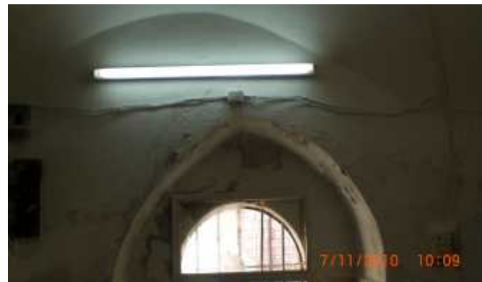
الشكل ( - ): رطوبة جدران فراغ رقم ( ). المصدر:- فريق العمل \ \
