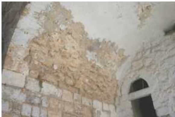
الشكل ( - ) : قات في الحلول الحجرية وتساقط الكحل. المصدر: - فريق العمل \ \
