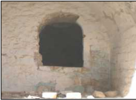
الشكل ( - ) : سقوط الحجارة والقموط حول الفتحات . المصدر: - فريق العمل / /
