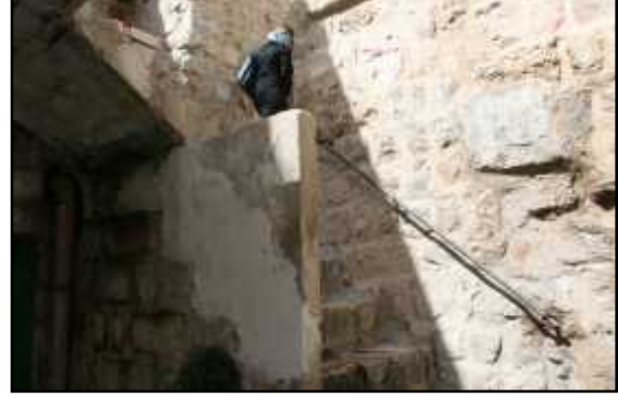
الشكل ( - ) : الأدراج الموجودة شمال غرب الفناء الداخلي. المصدر:- فريق العمل //
