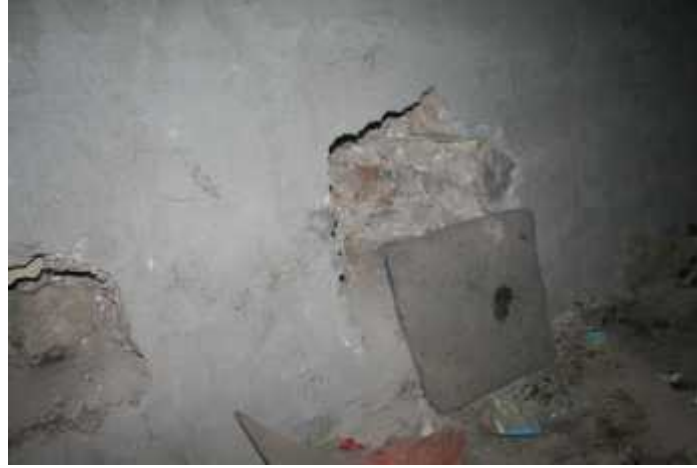
الشكل ( - ): تساقط حجارة جدران الفراغ رقم ( ). المصدر:- فريق العمل \ \
