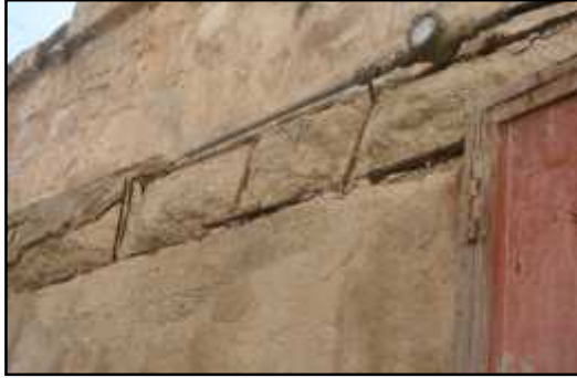
الشكل ( - ) : ظهور حديد التسليح والتمديدات في الواجهات. المصدر: - فريق العمل / /
