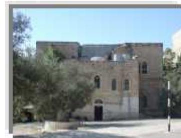
( - ) البناء القديم لمدرسة خديجة
