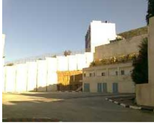
( - ) سور خلفي يحيط بالبناء
