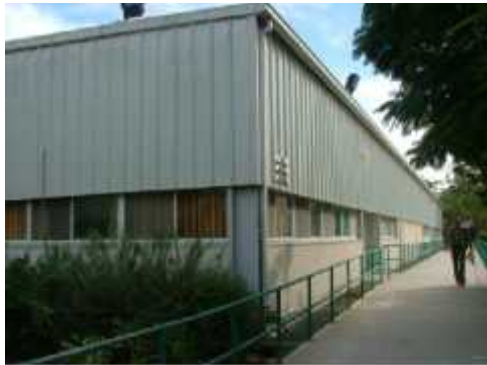
(56-3) الصورة توضح المخزن الرئيسي من الخارج : عدسة صديق.
