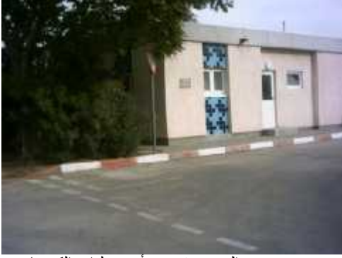
(3-59) الصورة توضح أحد مولدات الكهرباء
