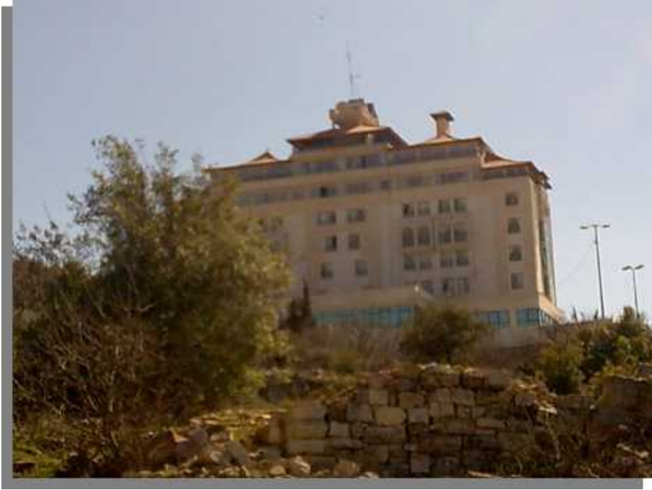
( - ) الواجهة الجنوبية الغربية للموقع يظهر فيها فندق الميزان فريق البحث. / /
