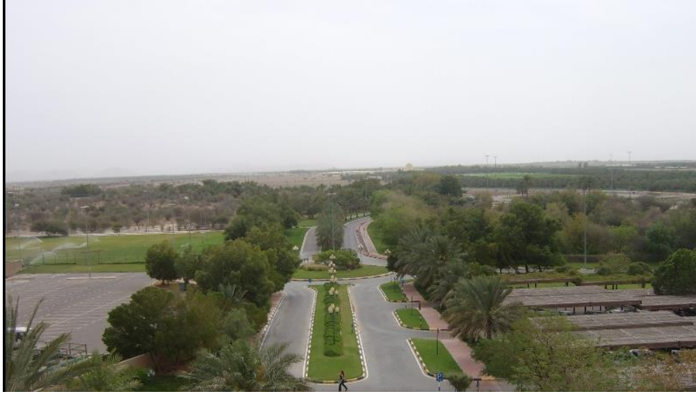
الصورة (4-18) : المدخل الرئيسي للمشروع ومنطقة الدوار الذي يربطه بالشارع المحيط (26)
