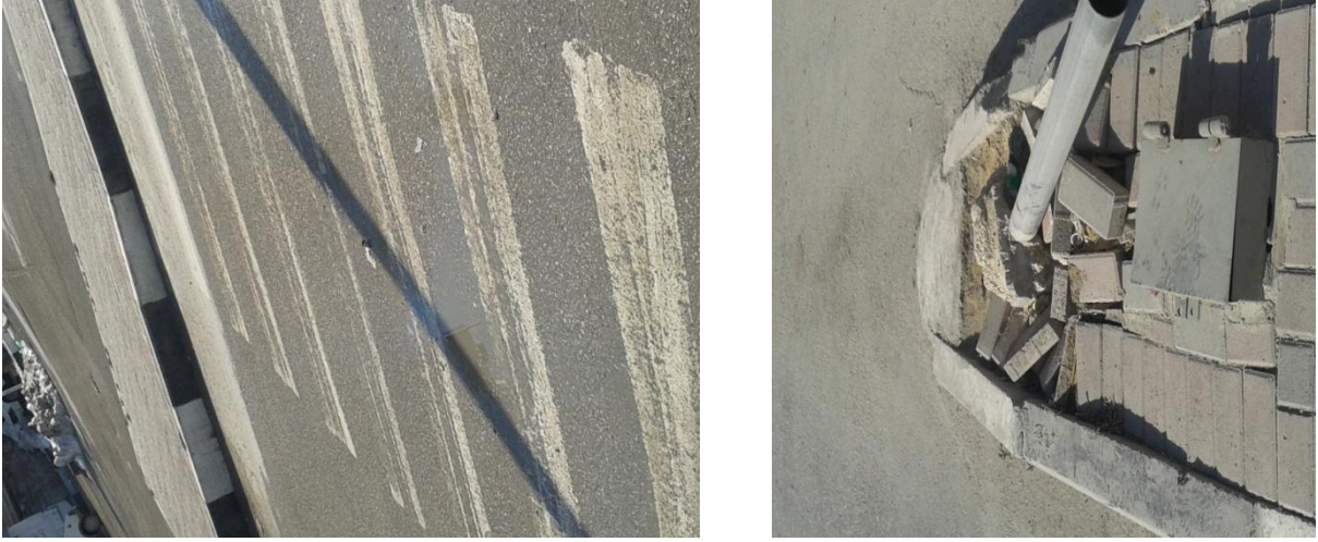
الشكل(4-4) عيوب اشارات المرور
