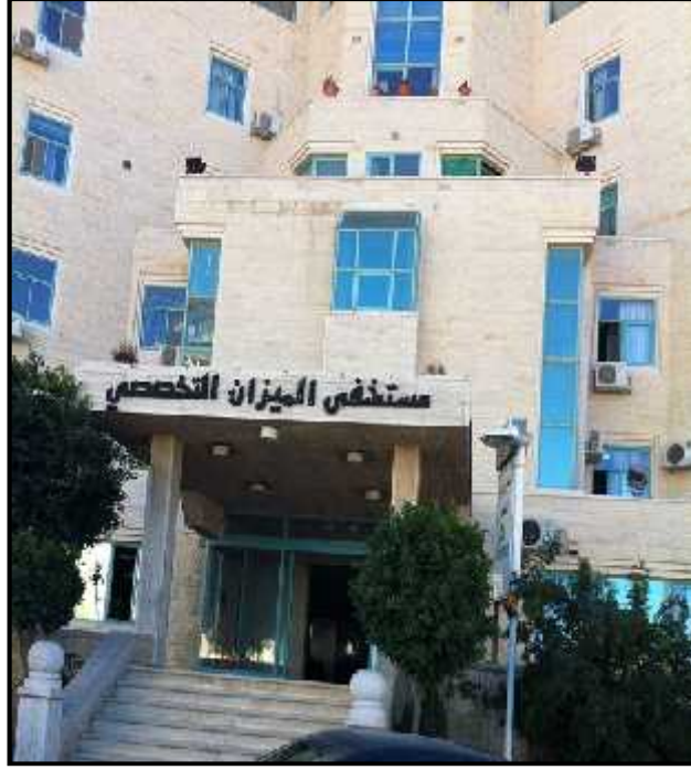
( . ) المدخل الرئيسي للمستشفى من الواجهة الأمامية فريق العمل :
