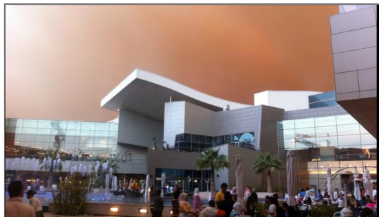
شكل (5.27) : الواجهة الرئيسية للمجمع
