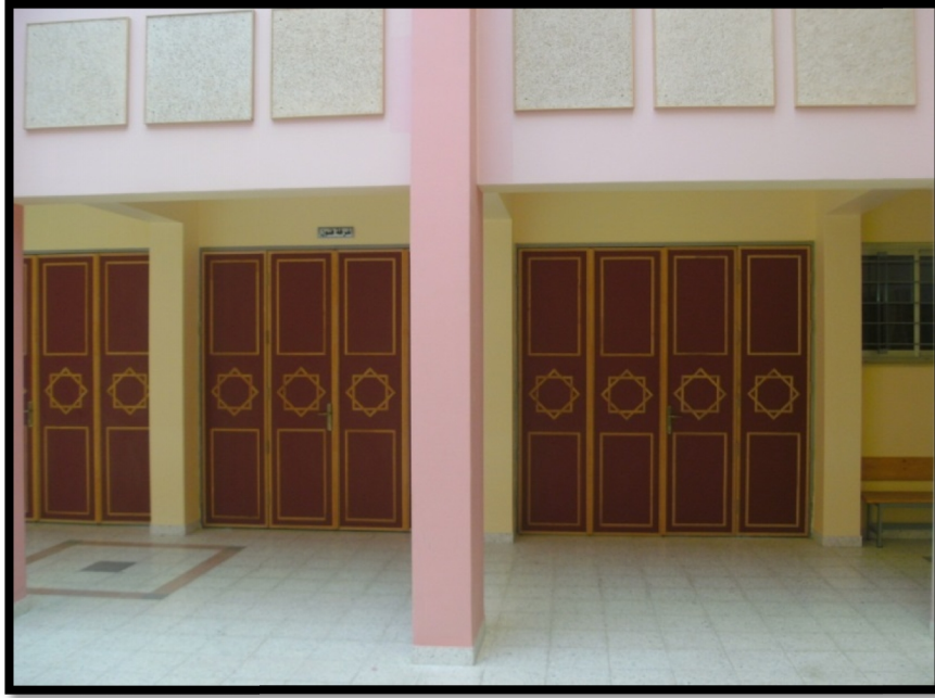
الصورة (٤-٥): الصورة مأخوذة من الساحة الداخلية في الطابق الارضي يظهر فيها مداخل صالة الفنون والحرف . المصدر : الباحثان، شباط ٢٠١٣ .
