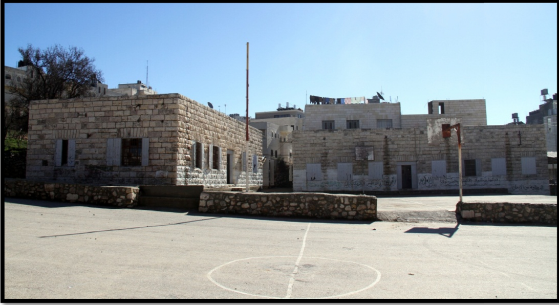
الصورة (٢-٤): الصورة مأخوذة من الساحة الخلفية يظهر المبنى رقم ٢ و٣.
