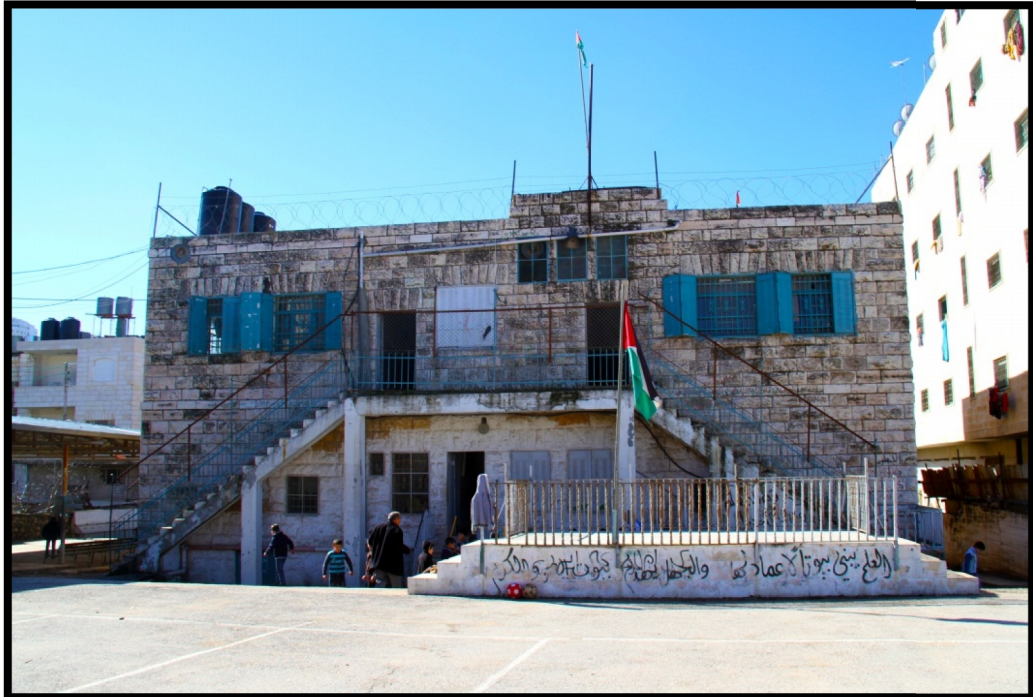
الصورة (٢-٣): الصورة تظهر الواجهة الخلفية للمبنى رقم ١. المصدر: الباحثتان ، شباط ٢٠١٣ .
