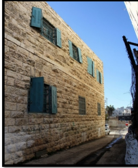
الصورة(٢-٦) : الصورة تظهر الممر الضيق الذي يوصل المدخل الرئيس بالساحة الخلفية المصدر : الباحثتان ، شباط ٢٠١٣ .
