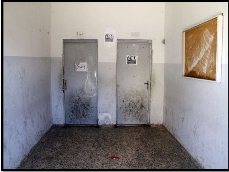
الصورة (٢-٢٣) : الصورة مأخوذة من موزع المبنى (٣) ويظهر فيه مدخل غرفتين صفيتين.
