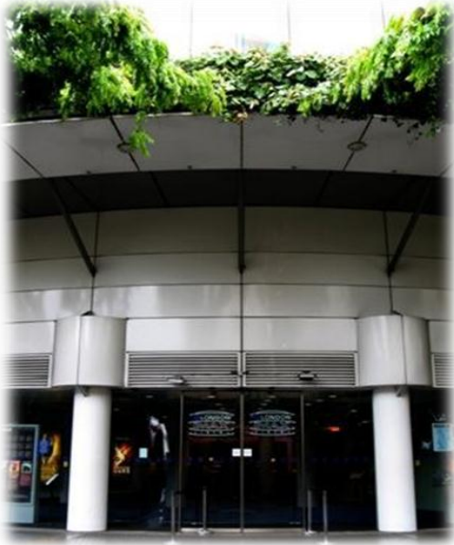
الشكل (3.4) : المدخل الرئيسي لسينما إيماكس المصدر: ( http://www.e-architect.co.uk/ london/bfi_imax.htm )
