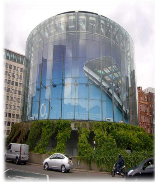
الشكل (2.4) : النباتات الخضراء المحيطة بالمبنى المصدر: ( http://www.e-architect.co.uk/ london/bfi_imax.htm )
