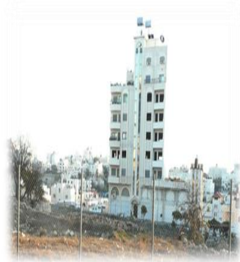
الشكل (11.6) : قطعة الأرض من الجهة الشمالية
