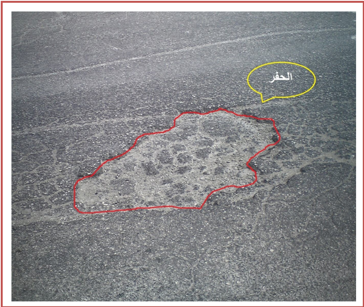
الشكل (٣-٤) : حفر ذات قطر وعمق مختلف
