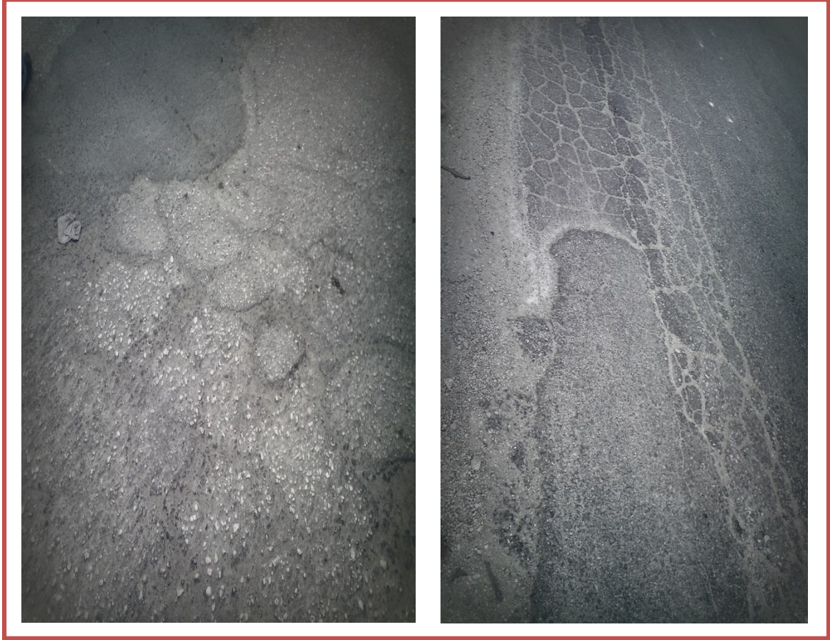
الشكل (٤-١): شقوق تماسحية واقعة على جوانب الطريق
