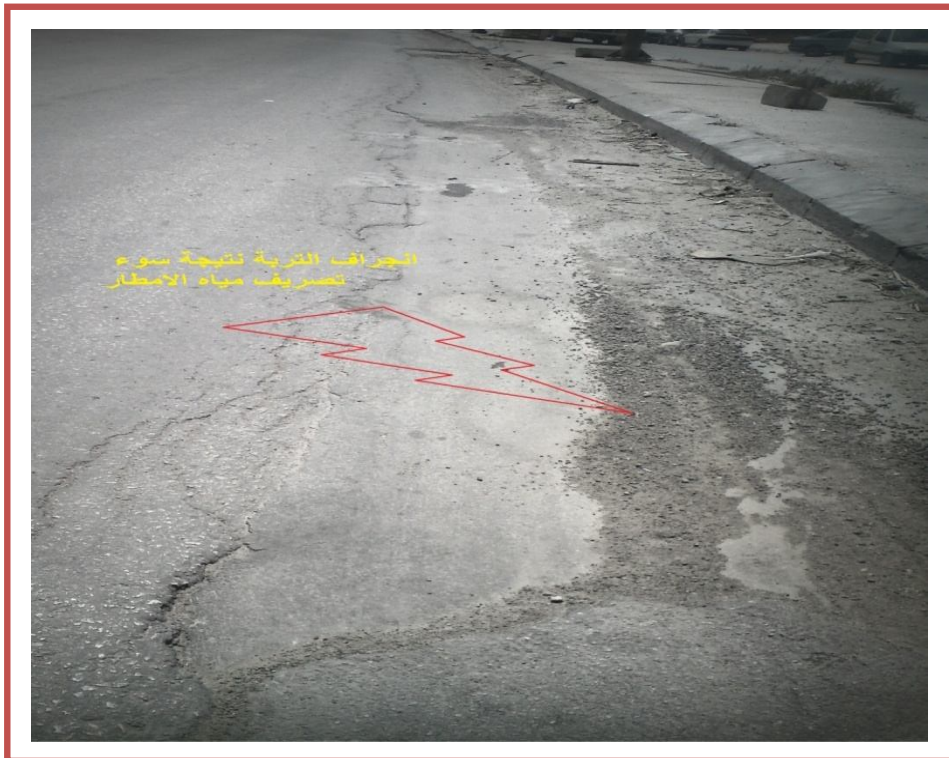
الشكل (٤-١٦): تأثير مياه الأمطار على جوانب الطريق
