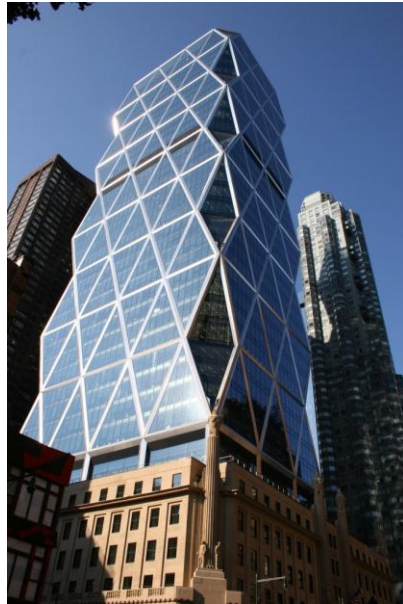
شكل (4-5): صورة تظهر فيها زوايا المبنى التي تشبه أفواه الطيور المفتوحة. المصدر:
