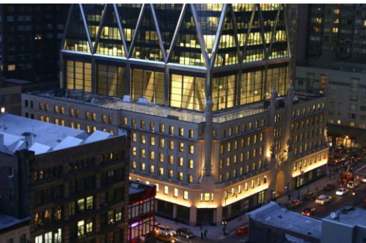
شكل (4-25): يبين الواجهات القديمة من البرج مضاءة. المصدر: http://forum.skyscraperpage.com/showthread.php?t=185727
