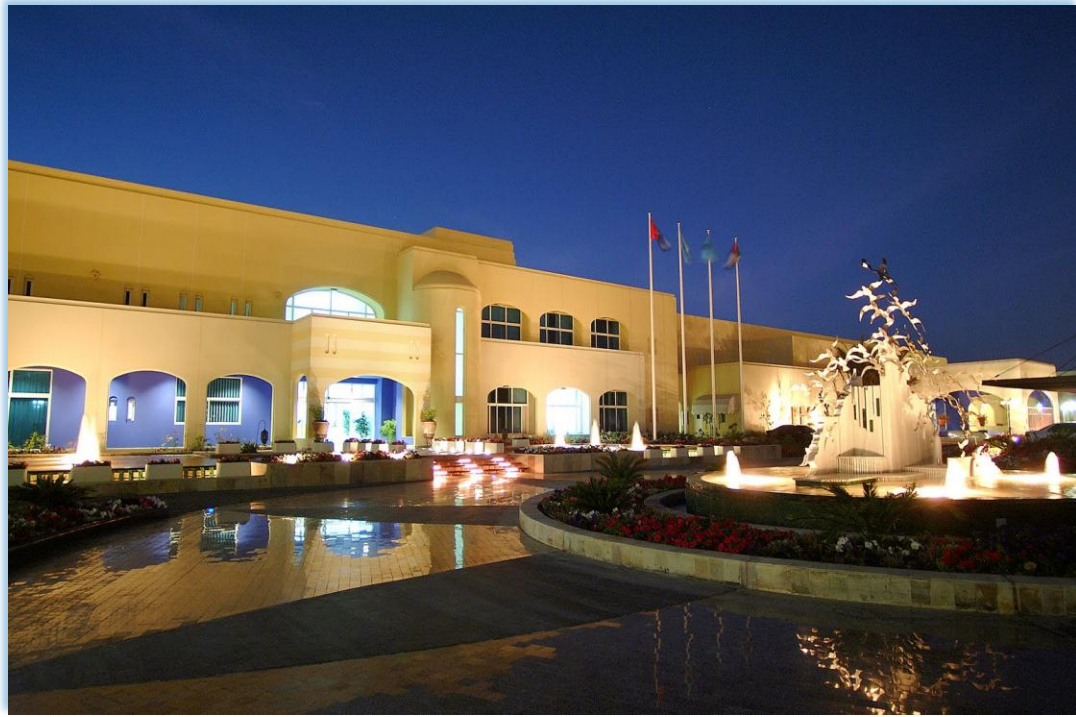
الشكل ( ١٨-٥ ) صورة توضح جزء من واجهة النادي
