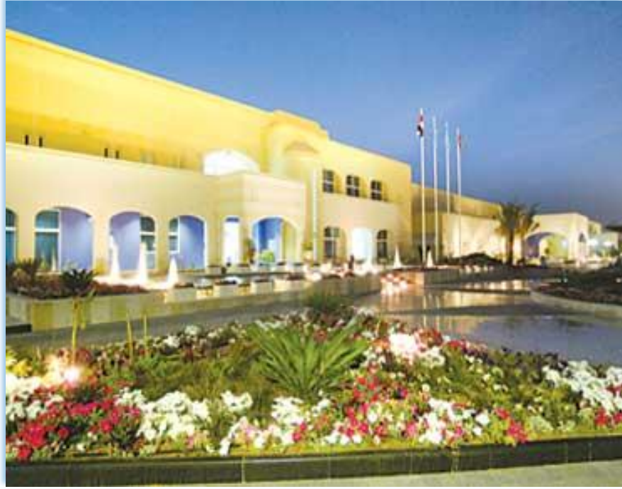
الشكل ( ١٩-٥ ) صورة توضح جزء من واجهة النادي
