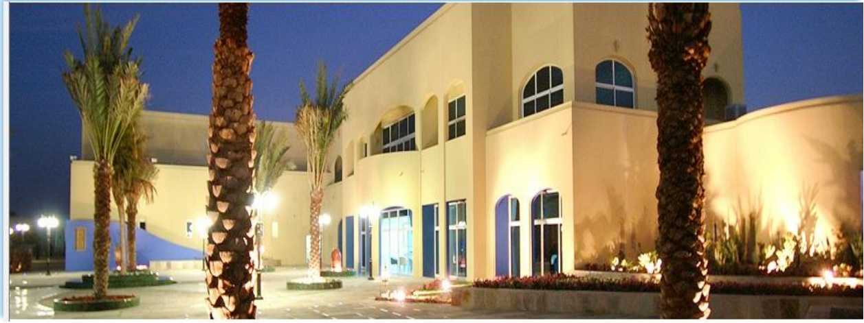
الشكل ( ١٧-٥ ) صورة توضح جزء من واجهة النادي
