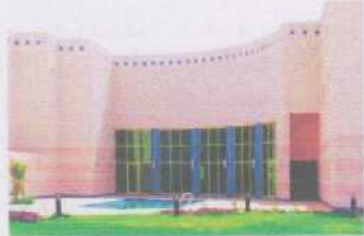
حديقة سكن السفير التي يقع عليها فراج العيشة على السطح وبسكن السفاريتها كغشاء لتمام المبنى . وتوزيع المساحة المصمم والحيثية جيد كون المباني متجانسة بها
