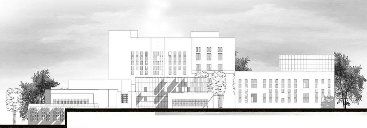
الشكل (٢-٢١) : الواجهة الغربية .
