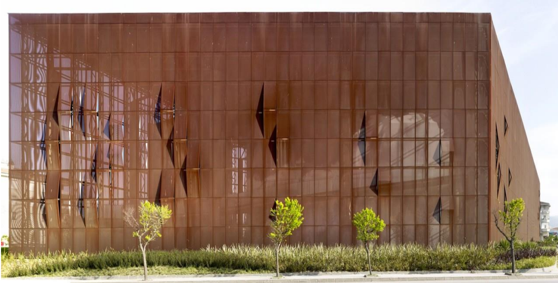
الشكل(٢٨.٤) (الغلاف الخارجي _ مركز رثيف الثقافي في مدينة يالوفا) المصدر (http://goo.gl/Ux1qje)
