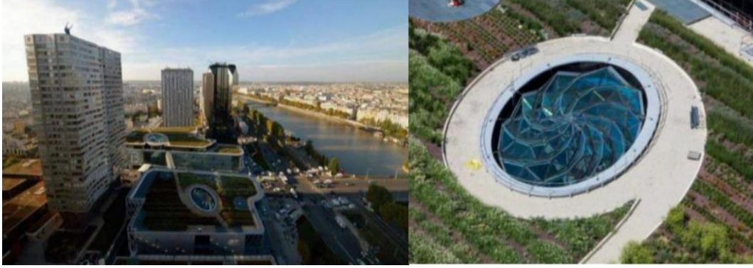
شكل(٤-٤) زراعة أسقف المركز.
