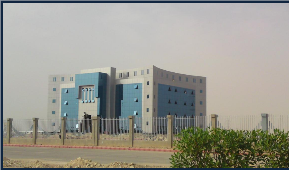
صورة (19.3) مبنى بلدية المنذب بعد التنفيذ المصدر : www.adslgate.com
