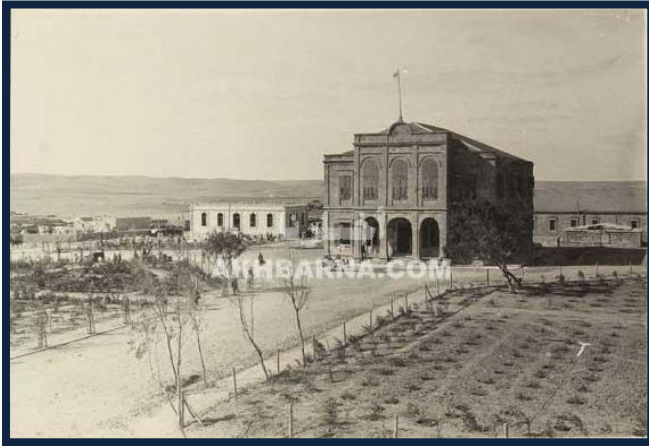
صوره ( 1.2 ) مبنى بلدية بئر السبع في العصر العثماني(صورة قديمة)
