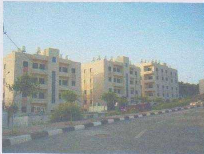
الشكل (٤-١٨) :- صورة توضح واجهات العمارات. المصدر ( الباحث )
