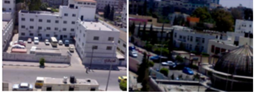
شكل (3.4) من اليمين مبنى مكتب تمثيل جمهورية مصر العربية، ومن اليسار وزارة الشؤون الاجتماعية. المصدر: مجلة العمران - العدد التاسع
