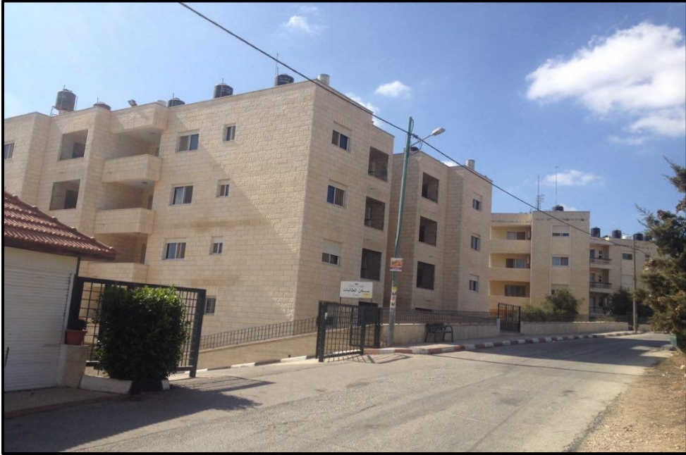
الشكل(4-9): واجهات المباني من الشارع الفرعي.
