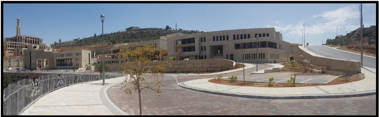
شكل (14.6): الواجهة الجنوبية (المصدر: فريق البحث)
