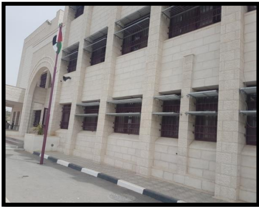
شكل (43.5): الواجهة الأمامية لمدرسة عسقلان، (المصدر: فريق البحث)
