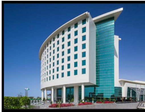
الشكل رقم (2.2.2.4) : مبنى فندق البيلسان / المصدر : موقع الفندق الإلكتروني
