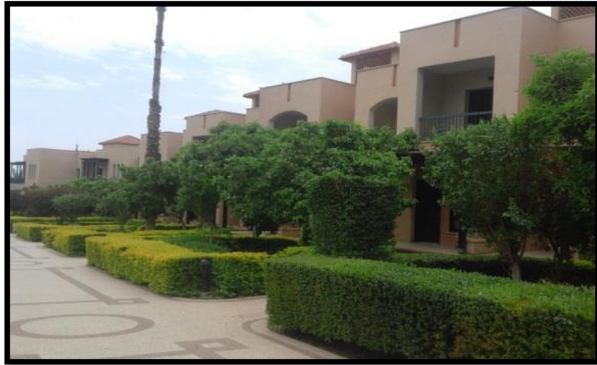
الصورة (13.1.4): شريط الشاليهات الشرقي/ المصدر: فريق العمل.
