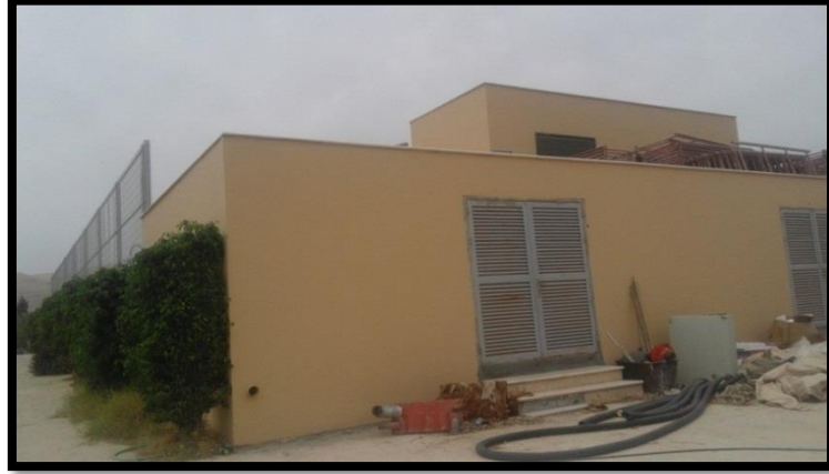
الصورة (11.1.4): مبنى الميكانيك (غربي الفندق)/ المصدر: فريق العمل.
