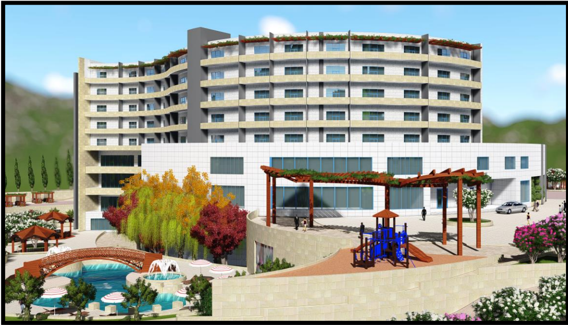
الصورة(4.4.8): الواجهة الغربية/ المصدر: فريق العمل
