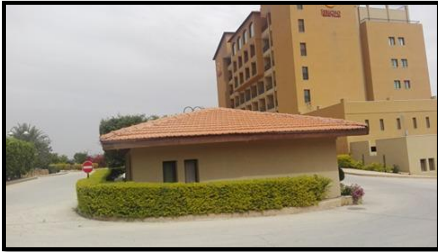
الصورة (10.1.4): مبنى سكن العمال (الواجهة الشرقية)/ المصدر: فريق العمل.
