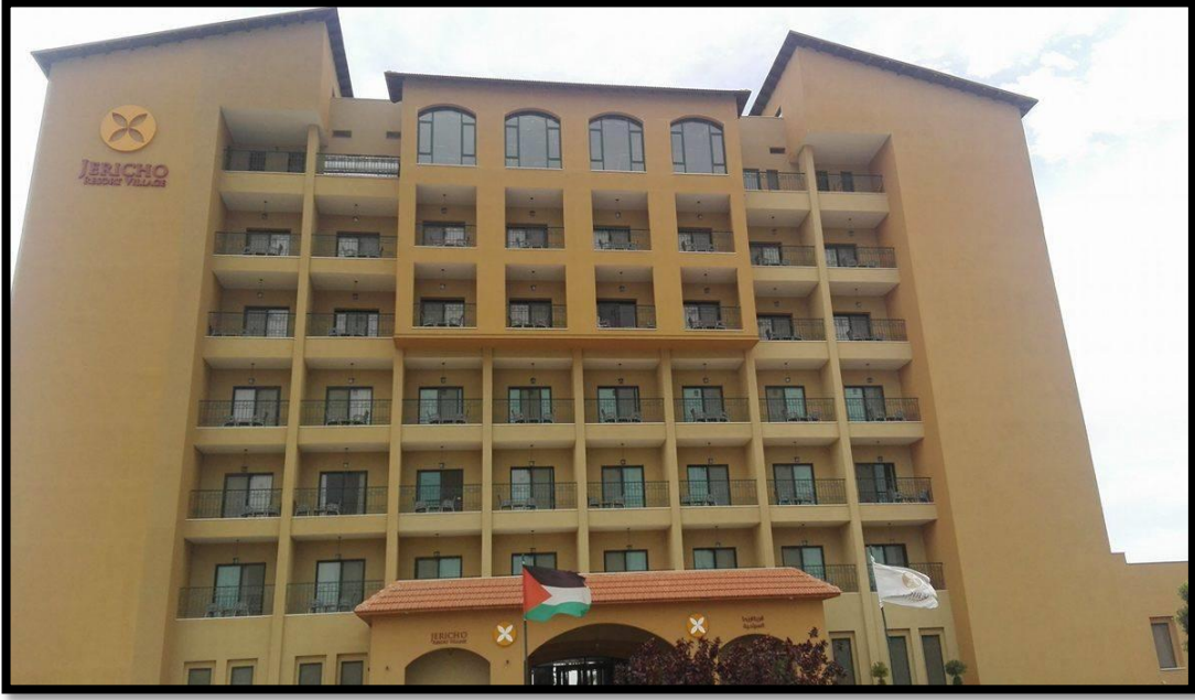
الصورة (19.1.4): الواجهة الشمالية/ المصدر: فريق العمل.
