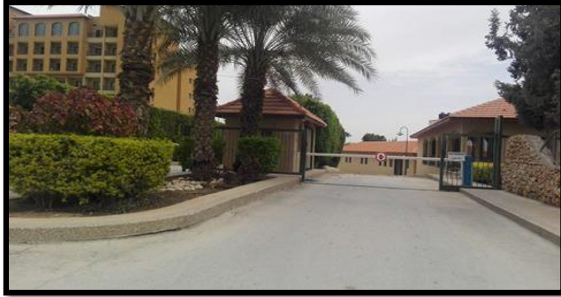
الصورة (6.1.4): المدخل/ المخرج الجنوبي/ المصدر: فريق العمل.
