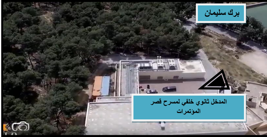
صورة (5-11) : توضح المدخل الثانوي الخلفي لمسرح قصر المؤتمرات. المصدر: موقع دنيا الوطن "بتصرف من فريق العمل.
